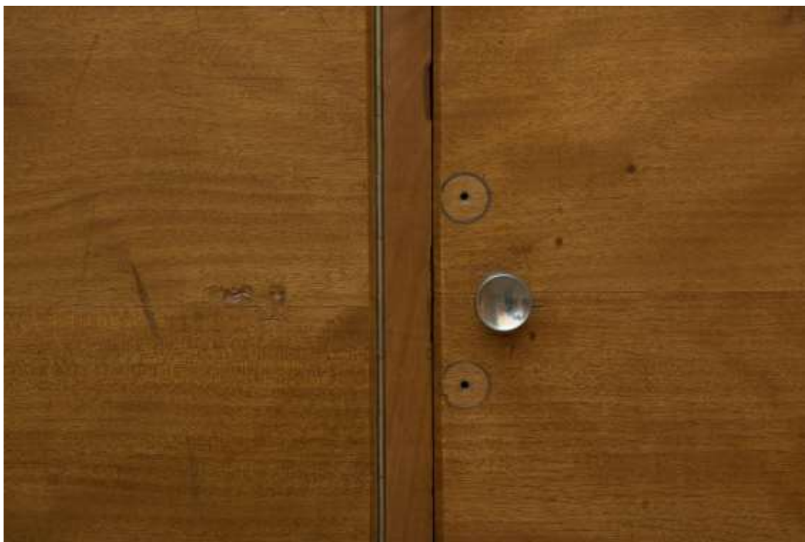
Detail poškození dýhy a omačkané hrany
